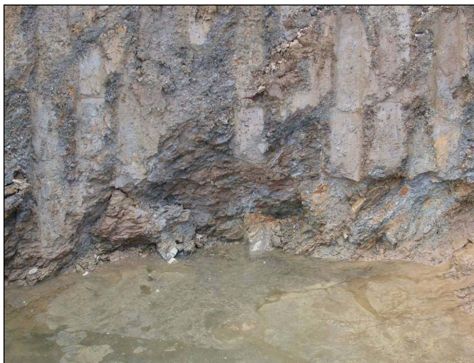
Fig. 12 – Formazione di Sillano affiorante nel paese di Cavallina in uno scavo di fondazione.
