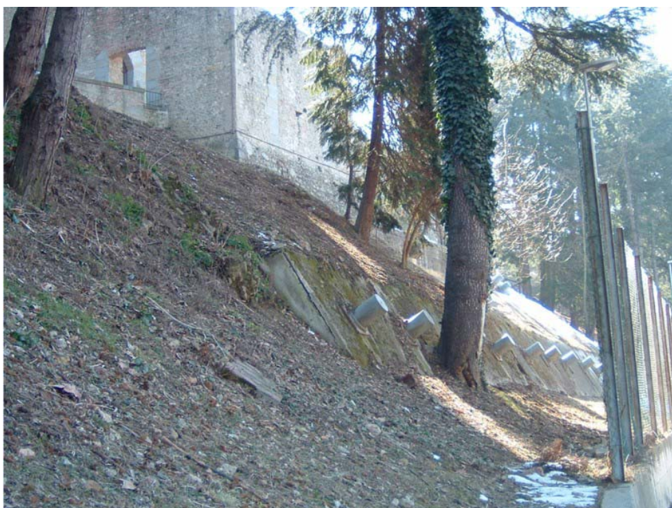
Fig. 3.12 - Opere di sistemazione di versante sotto il Castello di Scarperia
