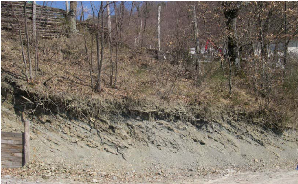
Fig. 3.6 – Contatto tra Marne varicolori di Villore (MVV) (a destra) e la Formazione dell’Acquerino (AQR1) affiorante lungo la strada che collega La Castellana a Marcoiano. In questo caso gli strati presentano una giacitura rovesciata.
