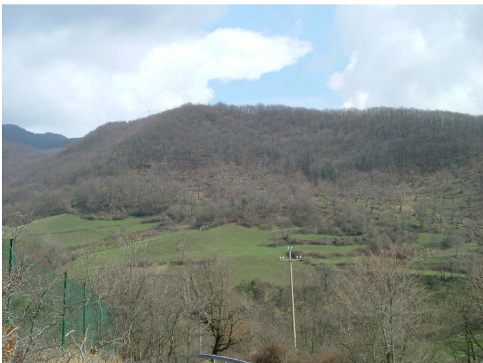
Fig. 3.9 - Vista panoramica della frana di ampie dimensioni a Nord di Castellana.
